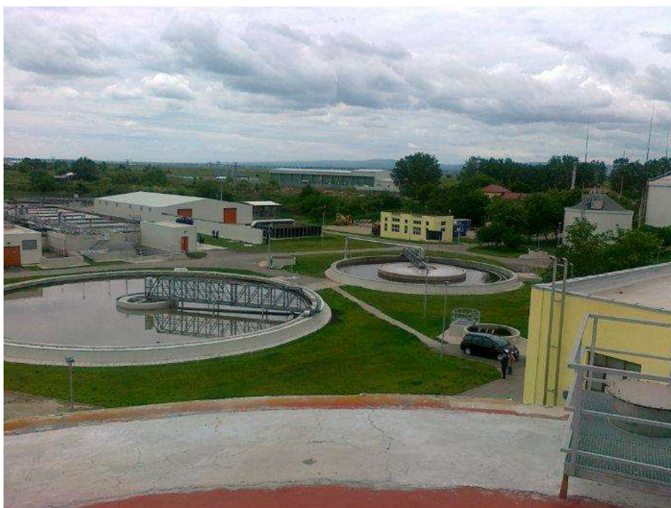
Statia de Epurare Focșani, sursa foto: https://wikimapia.org/10819483/Statia-de-Epurare
